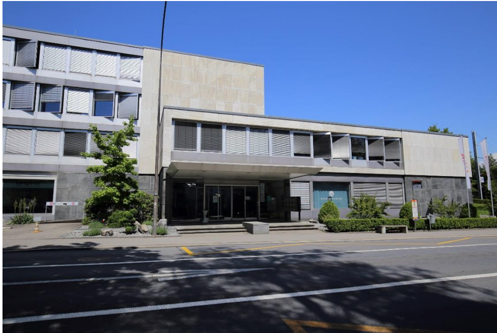
Bürogebäude Laubeggstrasse 70, 3006 Bern
